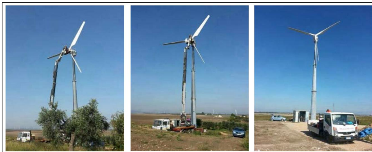
Abb. 49: Aufbau einer Kleinwindkraftanlage in Italien
