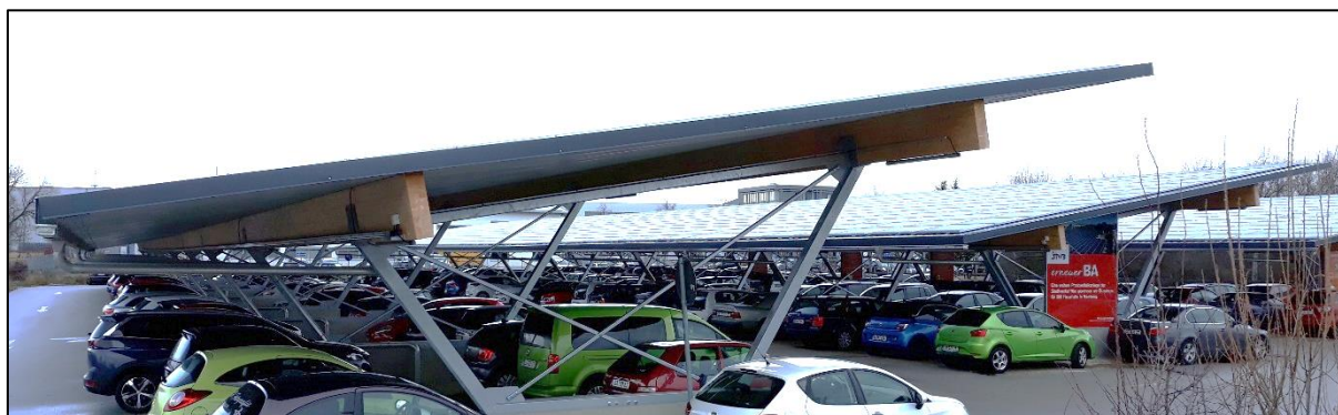
Abb. 43: Parkplatzüberdachung mit Ladestation (hier: P+R-Parkplatz am Gründerzentrum in Bamberg)
