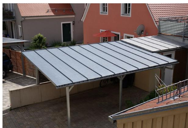
Beispiel einer Überdachung mit Zinkblech in handwerklicher Ausführung
